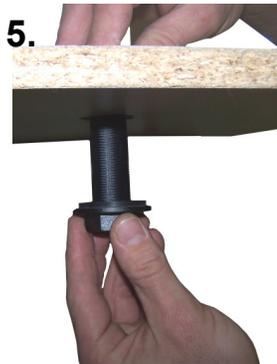
Par dessous, insérer la rondelle de caoutchouc et visser la noix de fixation noire
